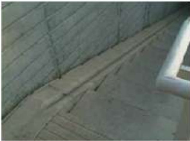
Figura 2-E.11: Diretrizes para o entorno da Estação – Detalhe de Referência – Rampa para bicicleta em escada; Fonte: Guia para projeto e gestão de facilidades para o Estacionamento de Bicicletas.
